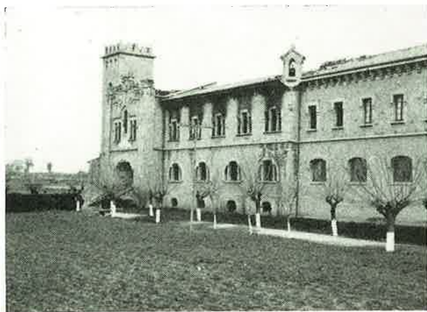
Vista exterior del Colegio. (Foto Llorca.)
