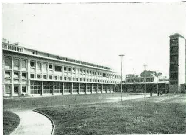
Vista general del patio de servicio.
